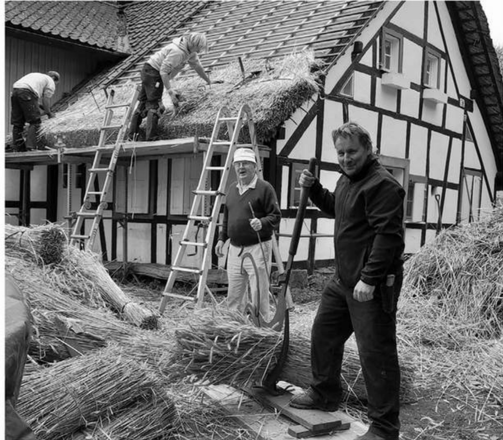
Ein ganzer Hof voller Stroh: In Höfen steht eines der letzten Häuser in der Region, die von einem Strohdach geschützt werden. In diesem Jahr war es an der Zeit, es zu erneuern. Rechts liegt das „alte Dach“, links liegen die Bündel für das neue Dach. Fotos (2): Carmen Krämer
